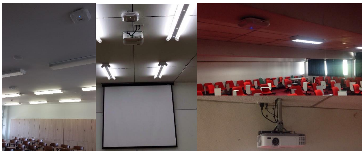
ภาพที่ 2 การติดตั้งอุปกรณ์กระจายสัญญาณภายในห้องเรียน
